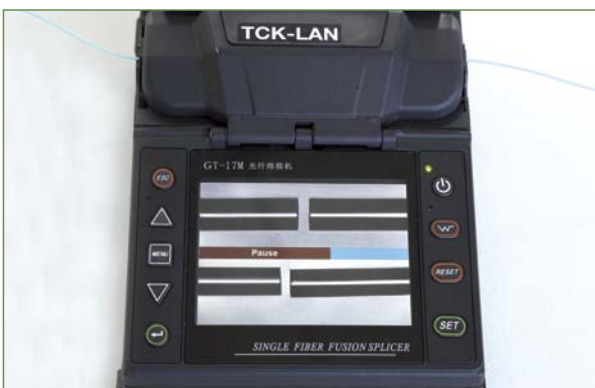
5 Eseguire la giunzione. La macchina effettua l'allineamento sul core.
